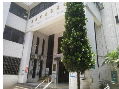
臺南市北區、東區 區公所
